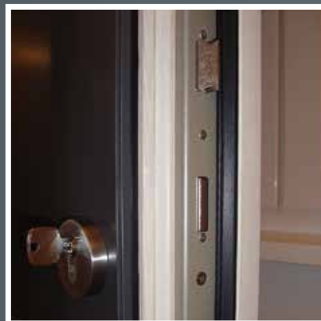
Aluminiumschale / Holztürblatt
